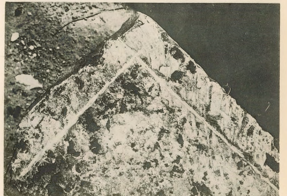
Tombe n° 4. — Un des quatre dépôts de fondation et un angle des fondations montrant les lignes de repère pour la construction.
